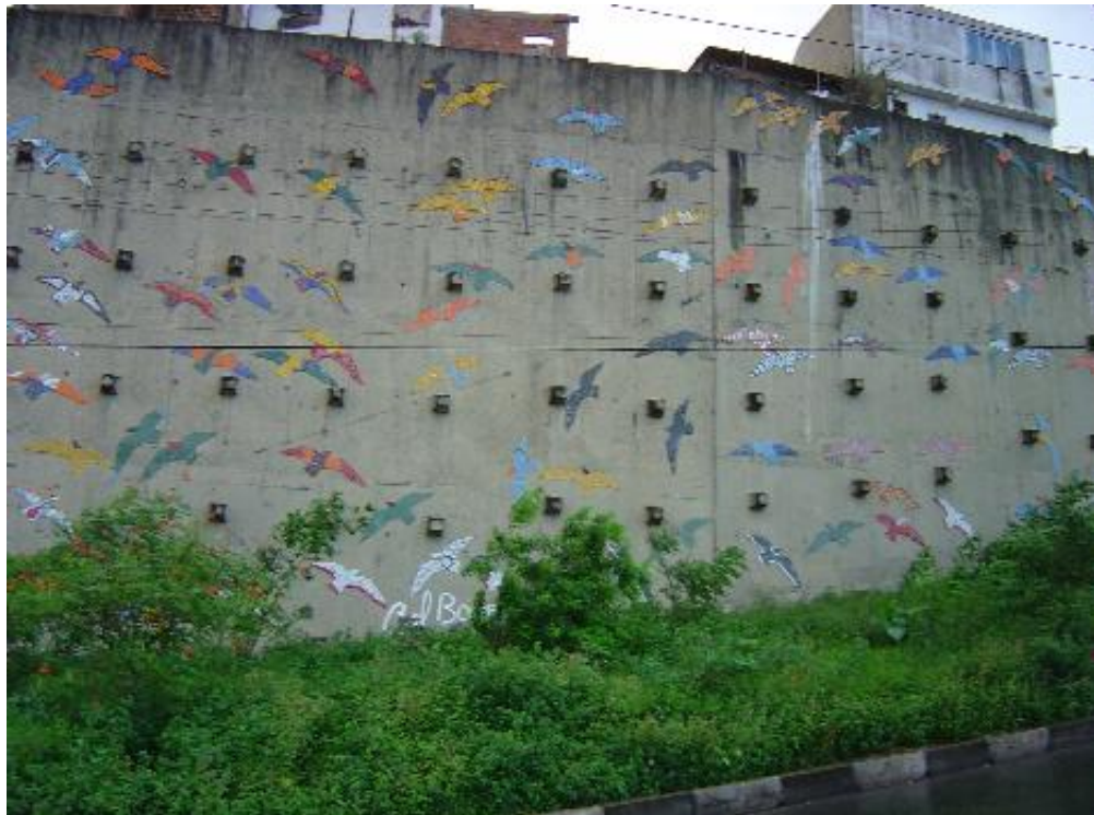
FIGURA 31 - Painel localizado no Bairro do Retiro, numa parede de contenção de encosta. Dimensões: 1.000 m 2 . Ano: 2000.
