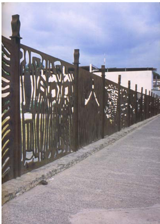
FIGURA 7 – Gradil de aço carbono, instalado na Casa Branca.
